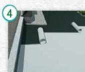
4 Posa l'antierbacce oppure la rete di drenaggio **SOLDRAIN** (che contiene l'antierbacce).
